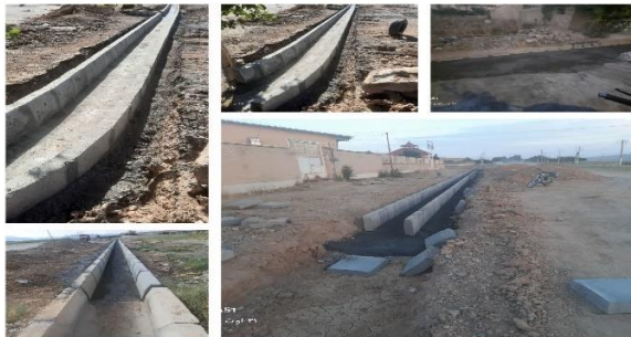
تعمیر و اجرای جدول معابر سطح شهر
