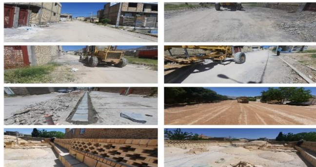
اجرای کانیوا و زیر سازی معابر سطح شهر و مرمت حمام قدیم علی آباد
